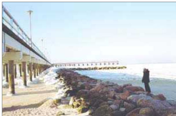
6 pav. Tinkamai sutvarkyti statiniai galėtų veikti kaip krantų stabilizavimo ir kaip bangų energetikos jėgainės
